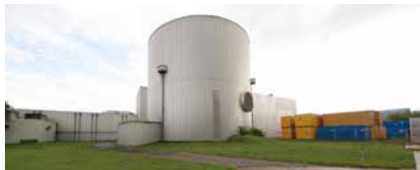
Kompakte Natriumgekühlte Kernreaktoranlage - KNK
