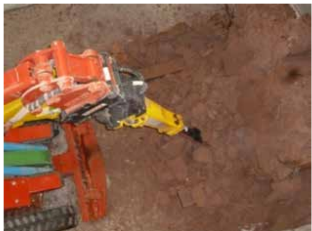
Ein modifizierter Bagger kann sowohl Werkzeuge wie Trennschleifer aufnehmen als auch mit dem Meißelhammer arbeiten.
