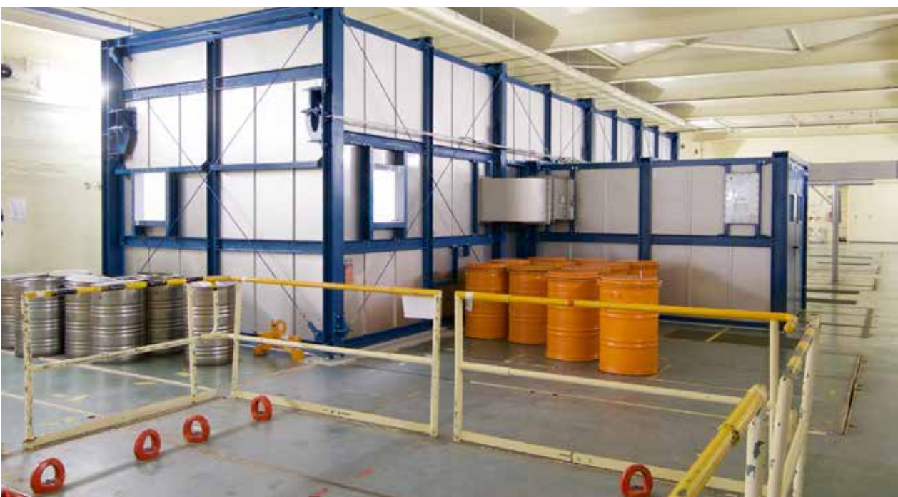
Blick auf die Ein- und Ausschleuseluke (vorne) und den Rückbaucaisson in der Kranhalle über den Zellen
