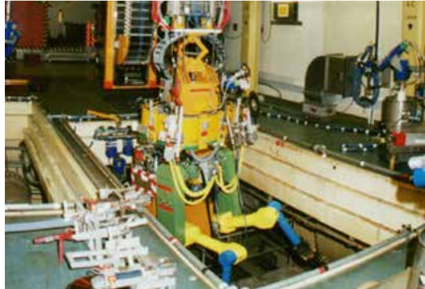
Fernhantierte Demontage der Prozesseinrichtungen
