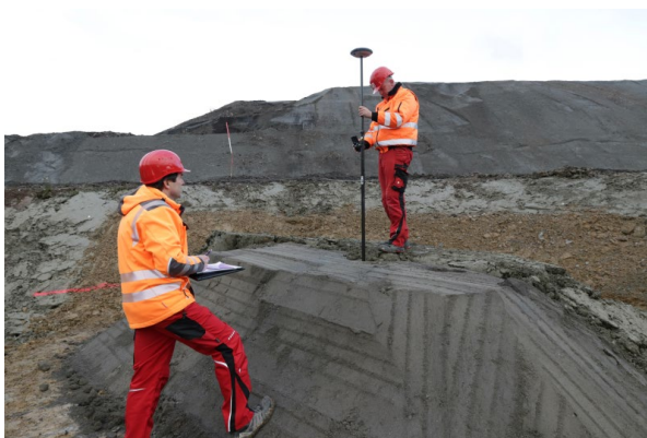
BU: Die Einlagerungsposition wird abschließend genau über GPS eingemessen.
