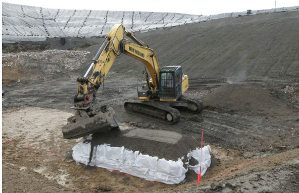
BU: Die Bigbags werden ohne Paletten im Einbaufeld positioniert und anschließend mit bereitgestelltem und geeignetem mineralischem Material abgedeckt.
