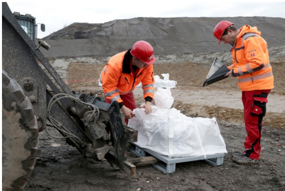
BU: An den Bigbags werden die Plomben überprüft und mit der Annahmedokumentation abgeglichen.
