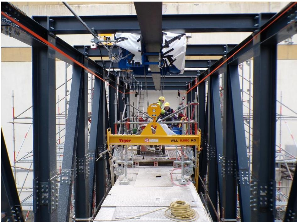
Die Wastebrücke ist abgetragen, die stützende Stahlkonstruktion und der Kran können deinstalliert werden.
