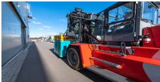
Das neue Lagergebäude L567 wird als Logistik- und Bereitstellungshalle genutzt. @KTE/Wolfgang Metzger
