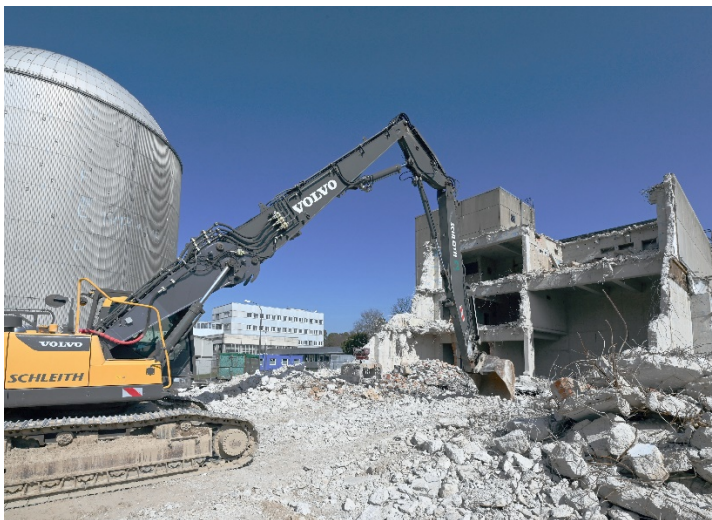
Abriß der freigegebenen Hilfsanlagegebäude B 916 – B 918
