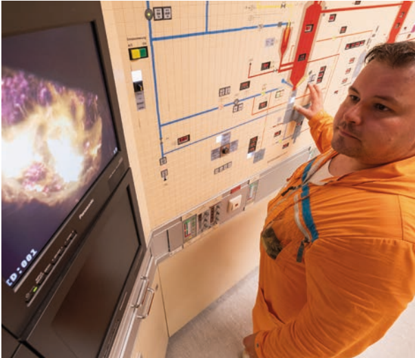
Know-how in der Abfallbehandlung: Mitarbeiter beim Steuern der Verbrennungsanlage.
