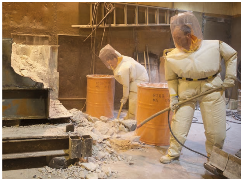
Vorbehandlung von Bauschutt für die Backenbrecheranlage.
