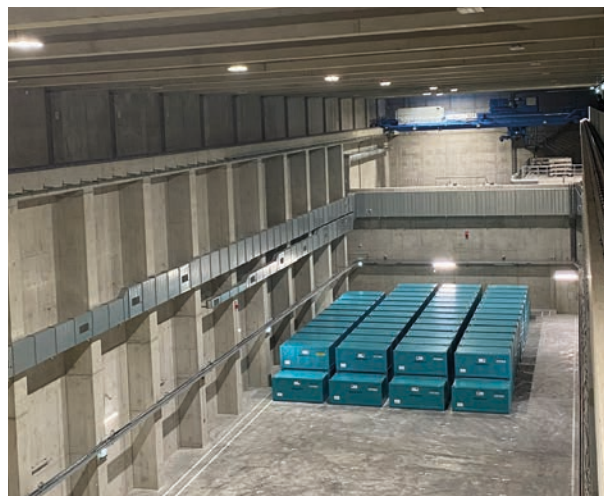
Blick in die neue Logistik- und Bereitstellungshalle L567.
