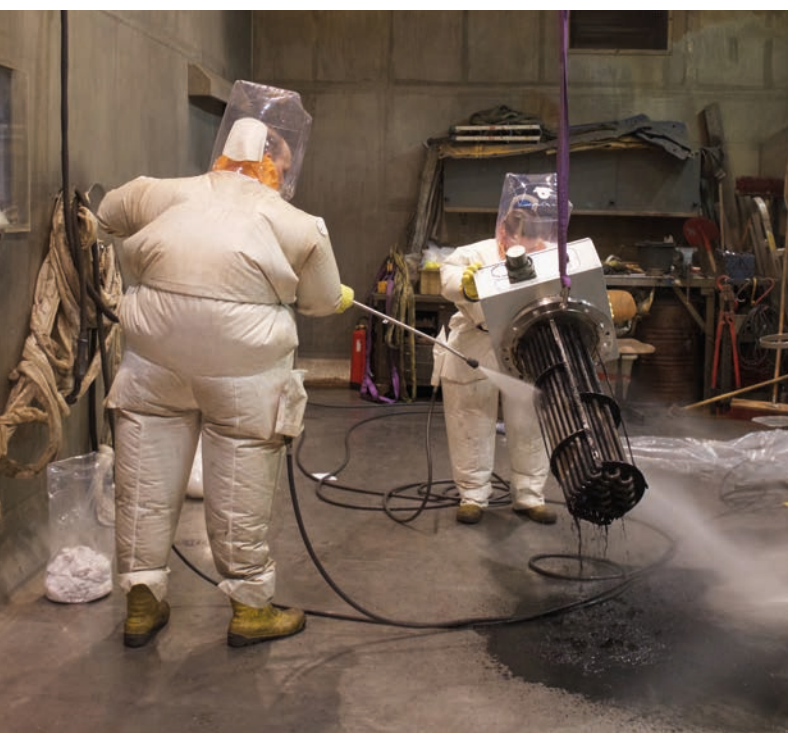
Hochdruckstrahlen entfernt Kontamination von der Oberfläche.
