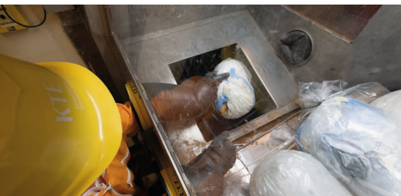
Feste, brennbare Abfälle werden dem Ofen zugeführt.
