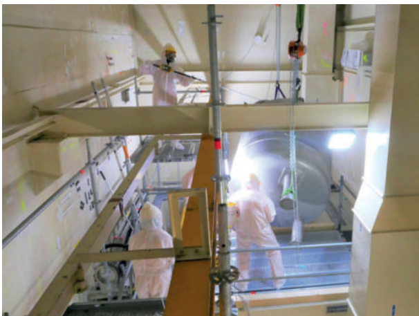
Demontage der Harzbehälter in der Maschinenhalle.
