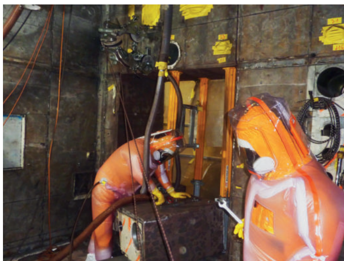
Manueller Rückbau in den Heißen Zellen.
