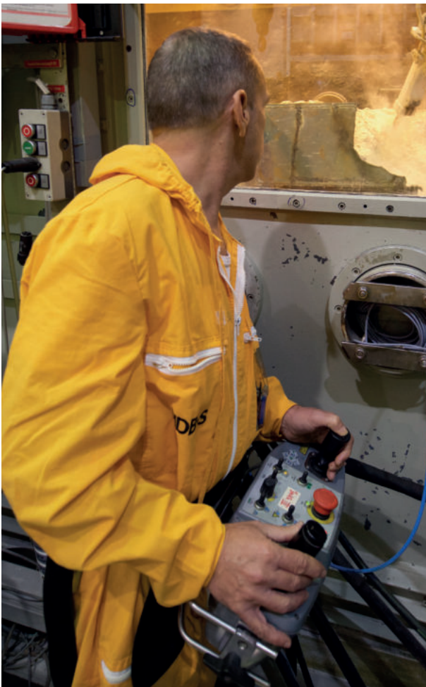
Arbeiten im Caisson mit Überwachung von Außen.
