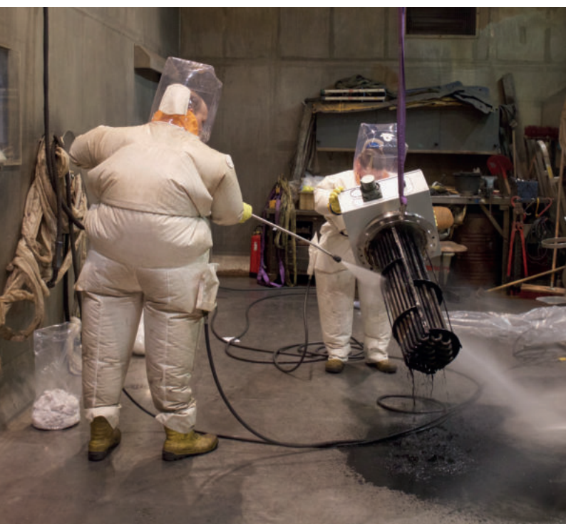
Hochdruckstrahlen entfernt Kontamination von der Oberfläche.
