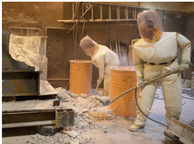
Vorbehandlung von Bauschutt für die Backenbrecheranlage.
