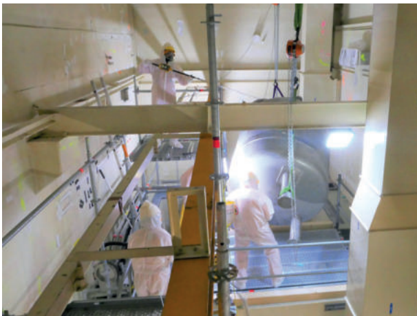
Demontage der Harzbehälter in der Maschinenhalle.
