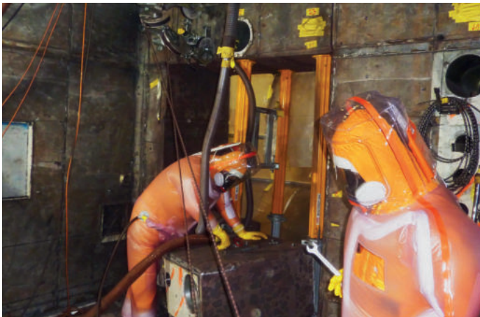
Manueller Rückbau in den Heißen Zellen.
