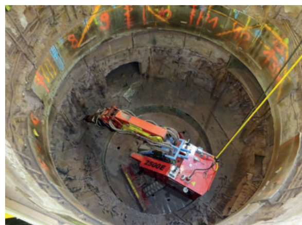
Stemmarbeiten am Biologischen Schild: Auf einer variablen Arbeitsbühne stehend, meißelt sich ein sonderangefertigter Abbruchbagger Stück für Stück vorwärts.
