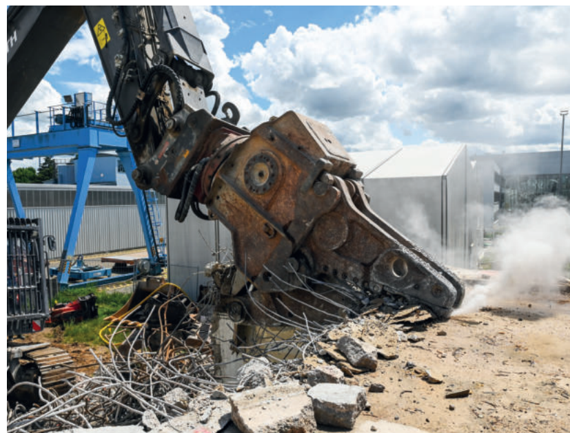
Im Mai 2022 wurde die benachbarte MAW-Eindampfungsanlage vollständig abgerissen.
