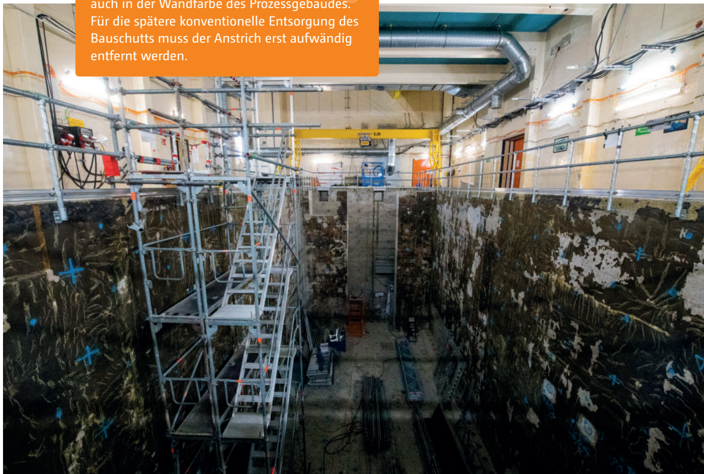
Wasserbecken mit Portalkran für den Abtransport der Betonblöcke.
