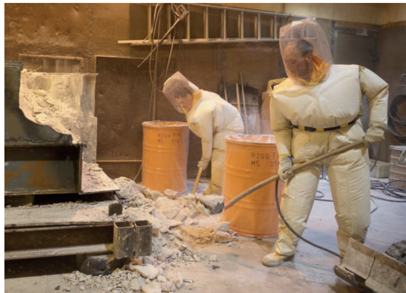
Vorbehandlung von Bauschutt für die Backenbrecheranlage.
