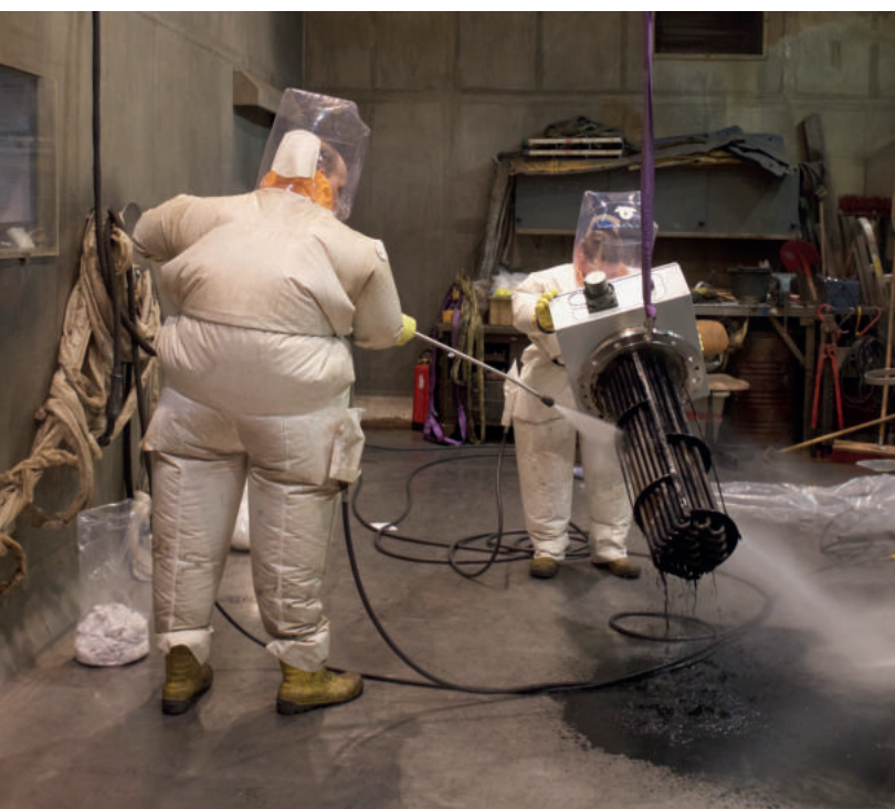
Hochdruckstrahlen entfernt Kontamination von der Oberfläche.
