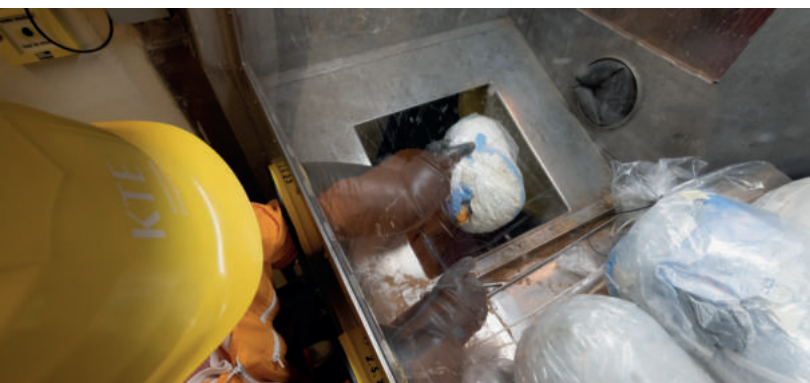
Feste, brennbare Abfälle werden dem Ofen zugeführt.
