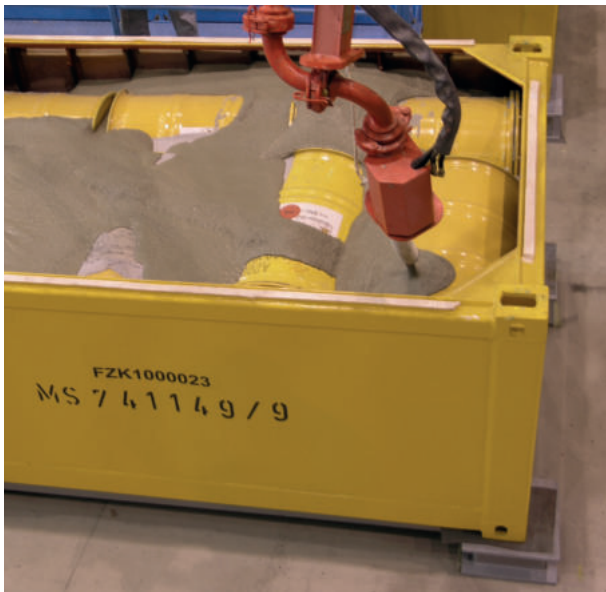
Im zweiten Schritt wird der Konrad-Container komplett gefüllt.
