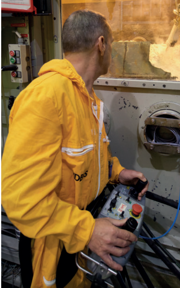
Arbeiten im Caisson mit Überwachung von Außen.
